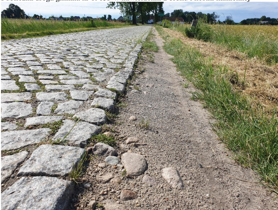
Publiczna droga gminna nr 2703F – istniejące pobocze gruntowe
