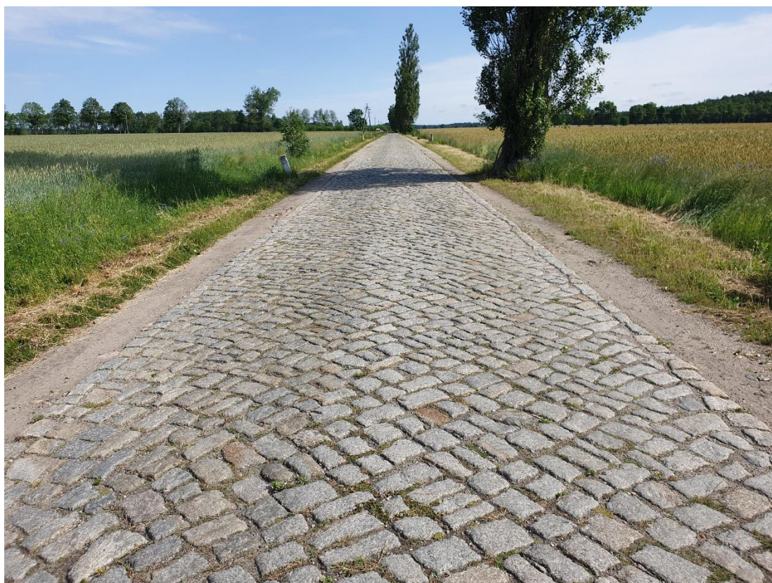
Publiczna droga gminna nr 2703F w nawierzchni z bruku i kostki kamiennej
