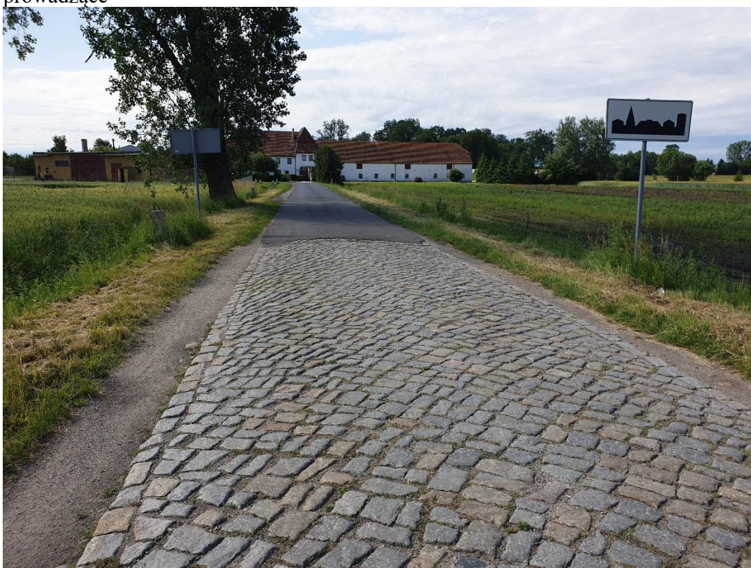
Publiczna droga gminna nr 2703F w nawierzchni z kostki kamiennej – dojazd do miejscowości – koniec planowanego remontu – istniejąca nawierzchnia bitumiczna.
