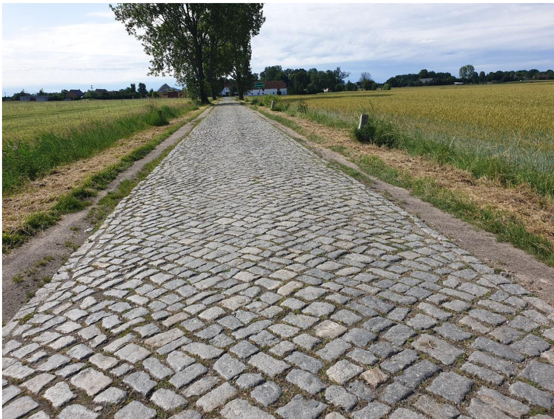
Publiczna droga gminna nr 1905F w nawierzchni z bruku i kostki kamiennej
